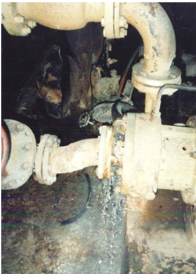
Foto 1. Generaatorgaasi puhastamine puhastus. As-lahuse lekked
